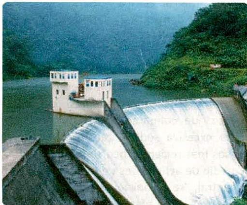
Imagen No. 25: Panorámica de la Central Hidroeléctrica del Bajo Anchicayá 53
