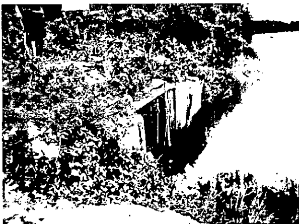
Fotografías 4 y 5 Entrada bocatoma Finca Kasuma sacos que presentan el deterioro por el arrastre de sedimentos ocasionados por el cauce del rio
