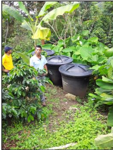
Foto 7. Detalle Sistema Tratamiento de Aguas residuales en El Pital (Huila)
