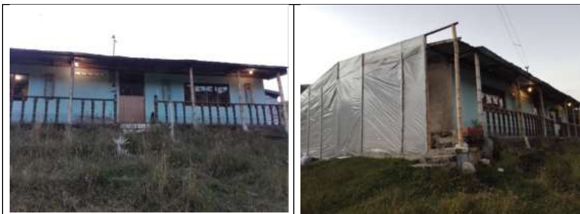
Imágenes 1 y 2. Fachada principal de la vivienda; muros en adobe y una fachada lateral en plástico.
