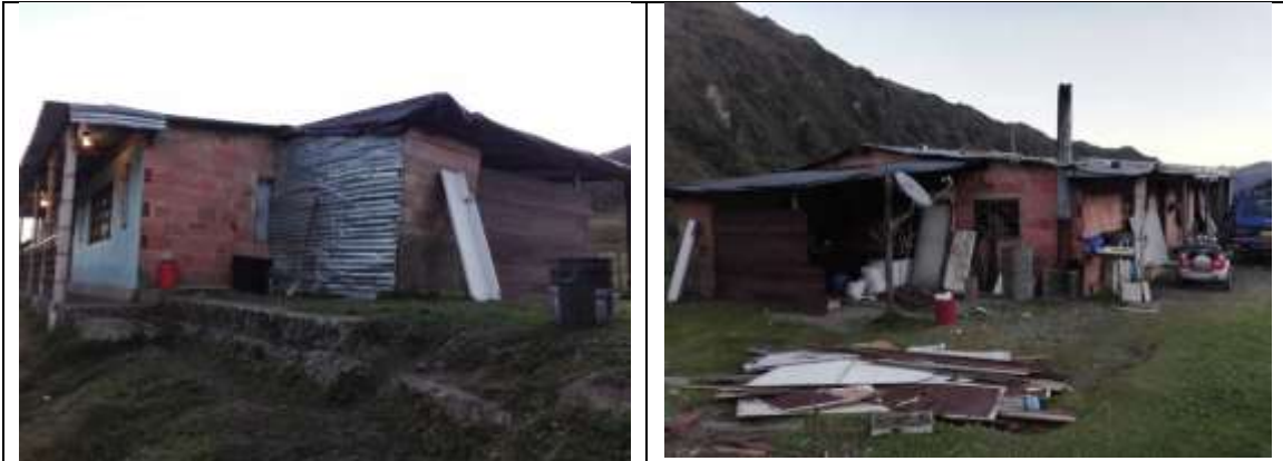
Imágenes 3 y 4. Fachada lateral y posterior con diferentes materiales (adobe, madera, zinc).
