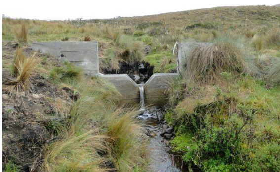
Figura 8. Ejemplos de vertederos de sección triangular.
