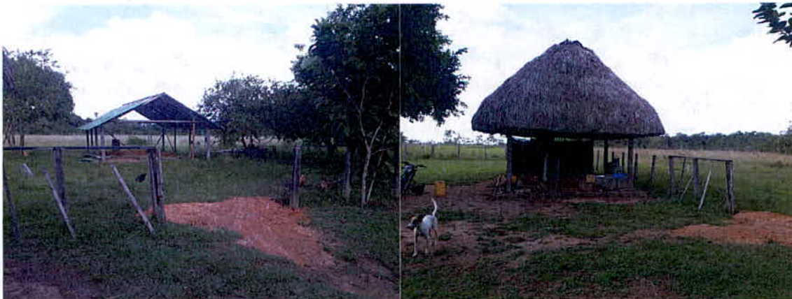
Infraestructura para ecoturismo en construcción (alojamiento para visitantes)
