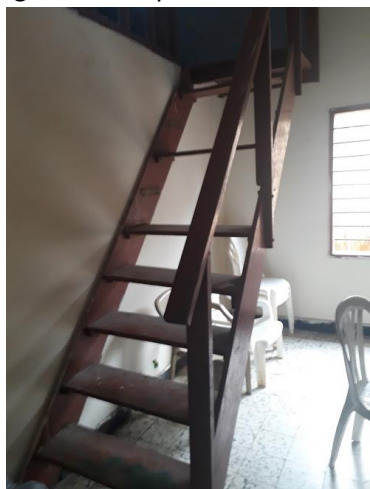
Fotografía 3. Escalera interna cabaña PNN El Zaino
