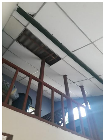
Fotografía 4. Techo cabaña PNN El Zaino
