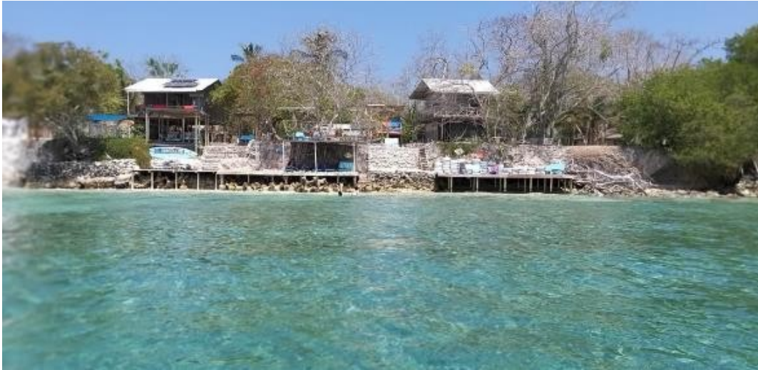
Fotografía 1. Vista panorámica de obras construidas en el "ecohotel El Hamaquero".
