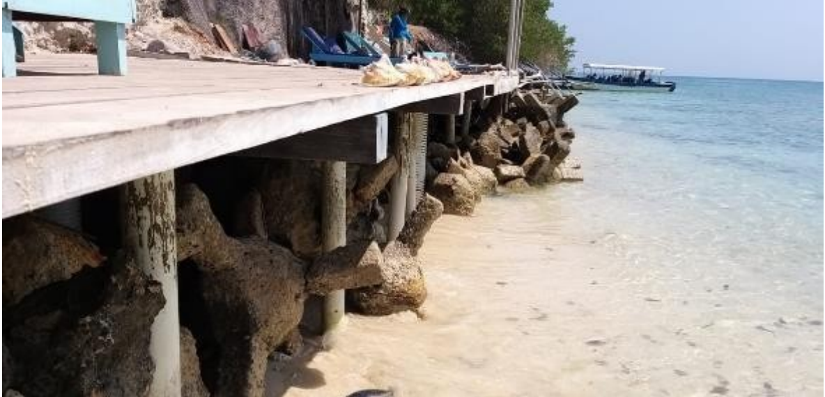
Fotografía 7. Registro de línea de hexápodos por debajo de plataforma como barrera de protección costera combinada con piedra coralina a forma de relleno.
