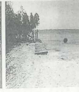
relleno con material de caracolejo
