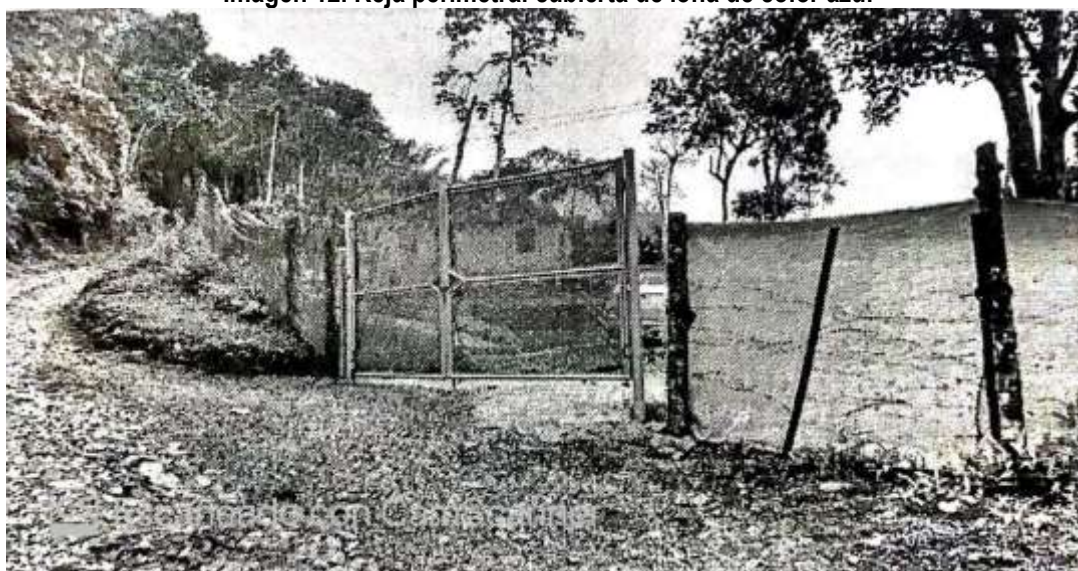
Imagen 12. Reja perimetral cubierta de lona de color azul
