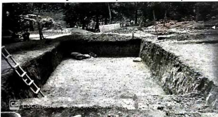
Imagen 1. Excavación para la construcción de piscina
