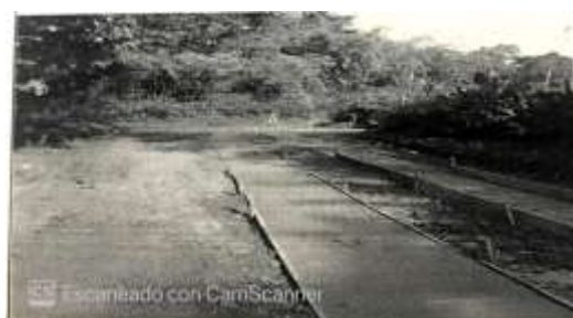
Imagen 17. Huellas con dos carriles
