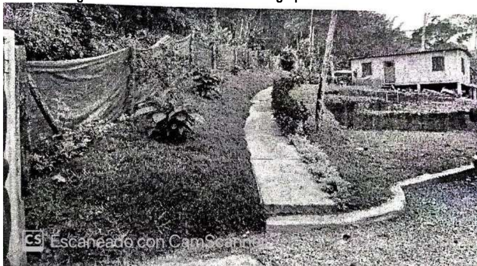
Imagen 11. Anden de 35 metros de largo por 1.1 metro de ancho
