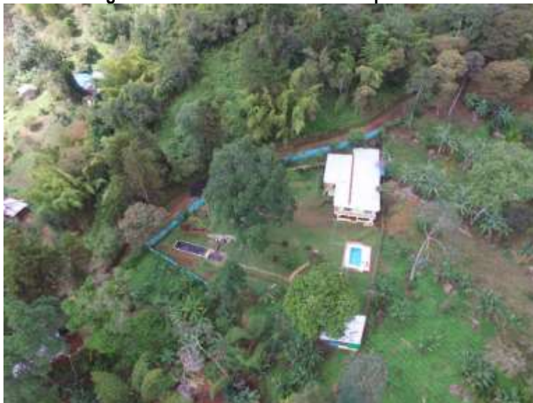
Imagen 4. Piscina terminada en vista panorámica
