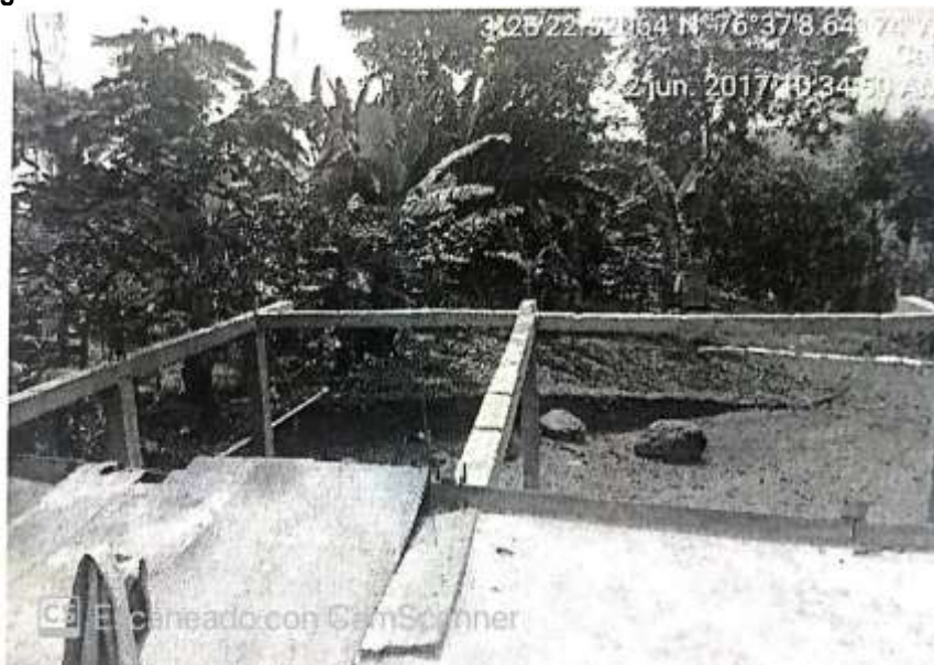
Tomada del informe de recorrido de campo del 2 de junio de 2017.
