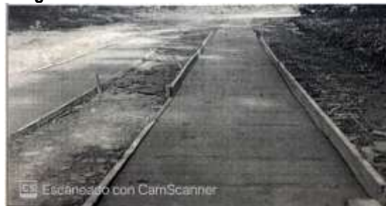
Imagen 16. Huellas con dos carriles
