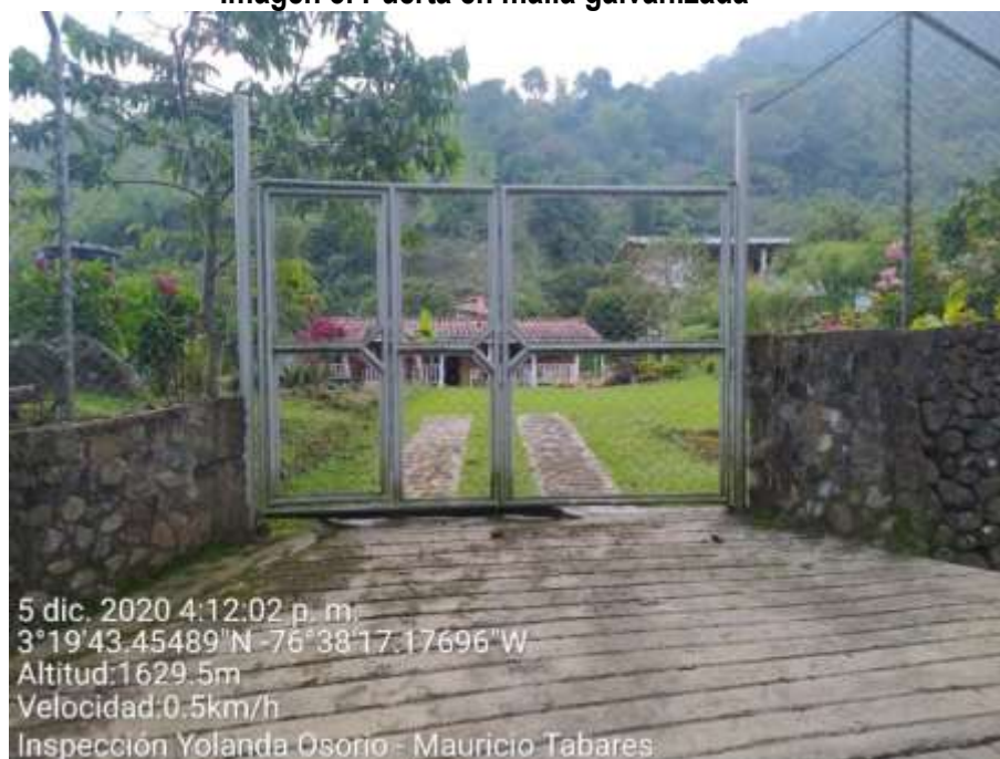
Imagen 3. Puerta en malla galvanizada
