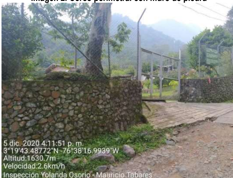
Imagen 2. Cerco perimetral con muro de piedra
