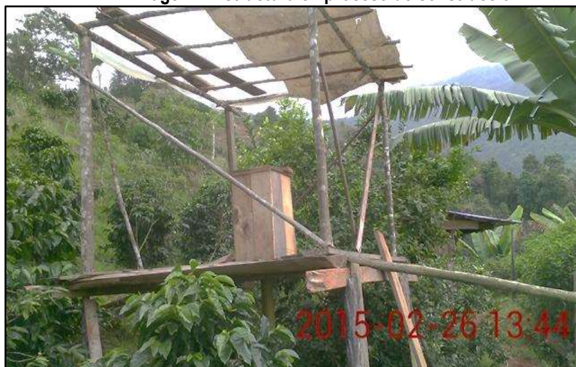
Imagen 4. Estructura en proceso de construcción
