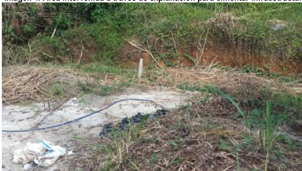
Imagen 4. Área intervenida a través de explanación para cimentar infraestructura
