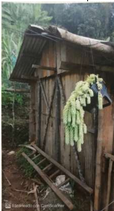
Imagen 7. Parte lateral de la infraestructura tipo vivienda ya terminada
