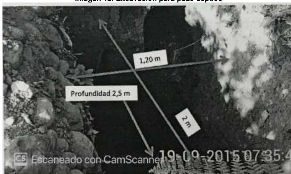
Imagen 12. Excavación para pozo séptico
