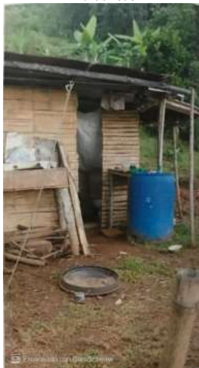
Imagen 8. Infraestructura tipo vivienda terminada donde se evidencian instalaciones hidráulicas
