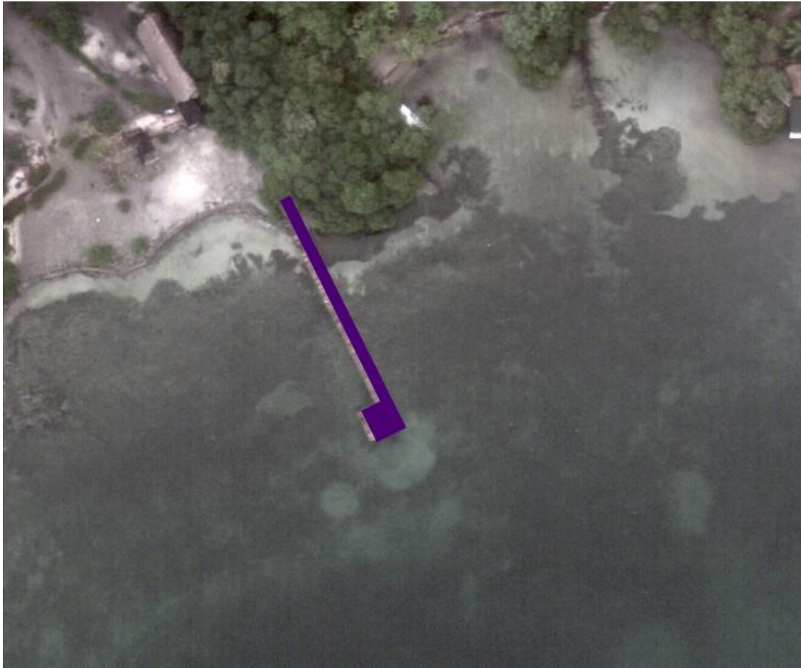
Figura N° 3. Imagen actualización de censo de muelles y espolones 2012 donde se evidencia la existencia de la estructura de acceso tipo embarcadero ubicado en el predio Tres Banderas, reparado irregularmente como acceso al predio los Totumos en jurisdicción del PNNCRSB.
