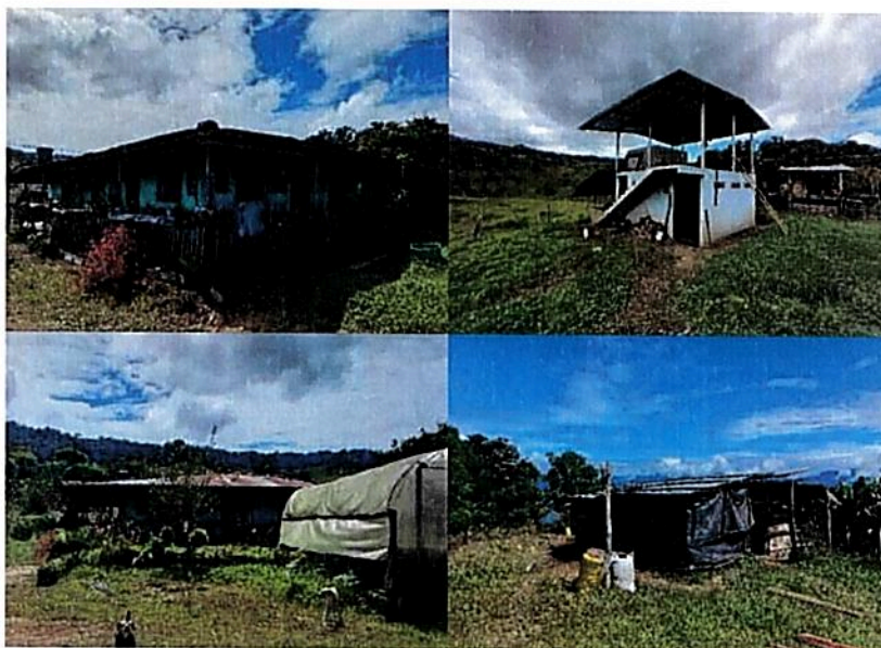
Figura 8. Zona de uso intensivo e infraestructura del predio "LOTE N1-VERSALLES" de la RNSC "VERSALLES", FMI No. 204-41928.
