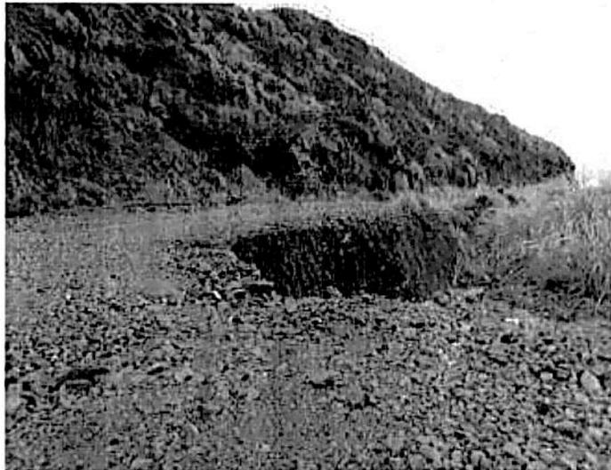
Fotografía 9. Estado actual de la vía de acceso a la Estación RTVC (erosión de la banca por escorrentía).
