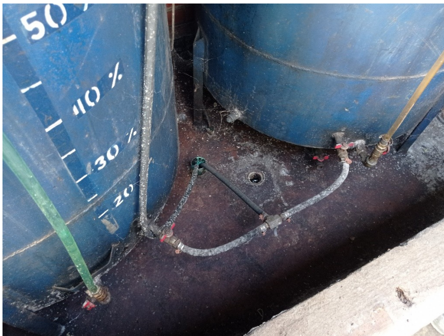
Imagen 3. Hallazgo de una posible infiltración de combustible en el piso de dique de contención de derrames en la estación Don Diego
