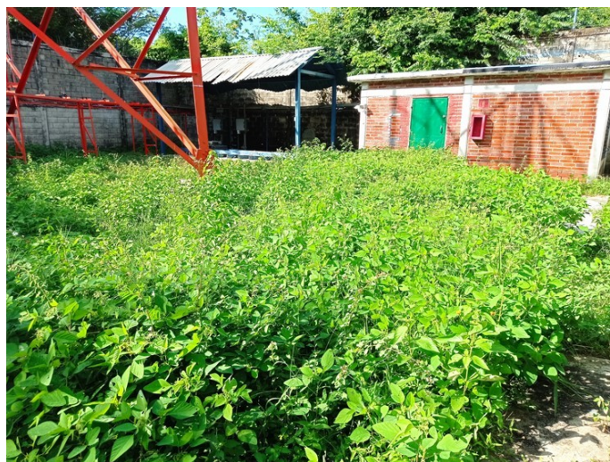
Imagen 5. Presencia de pastos y plantas herbáceas al interior de la Estación Don Diego 10. Mantenimiento y demarcación de senderos que conducen a la estructura PPMIA-10.
