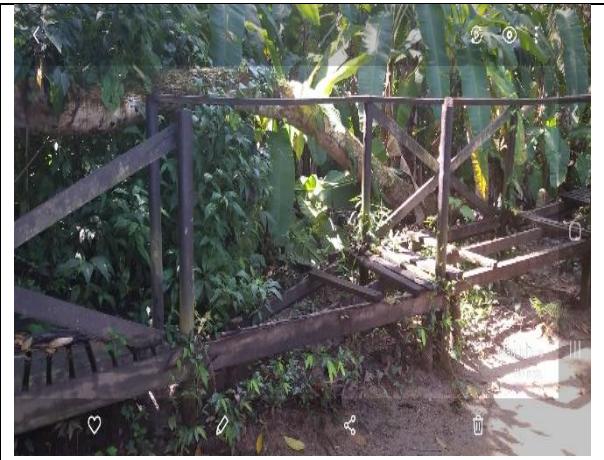
14. Puente corredor peatonal de visitantes Sector Zaino.
