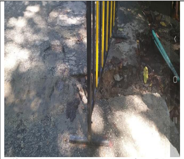
12. Vía vehicular de acceso de visitantes Sector Zaino.
