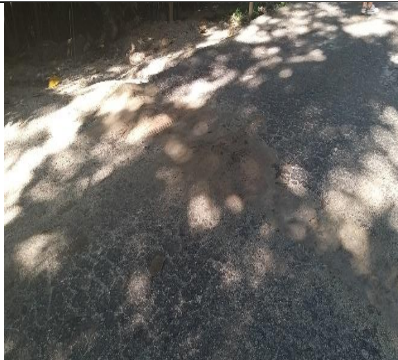
11. Vía vehicular de acceso de visitantes Sector Zaino.
