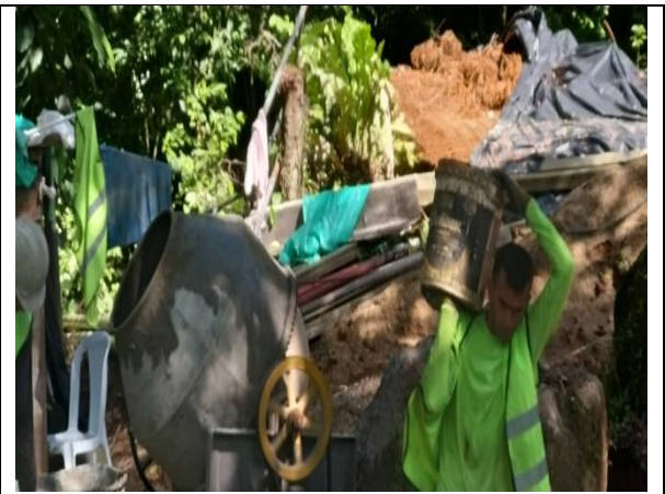
10. Obra en construcción acceso a visitantes Sector Zaino.
