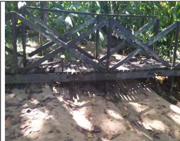
13. Puente corredor peatonal de visitantes Sector Zaino.
