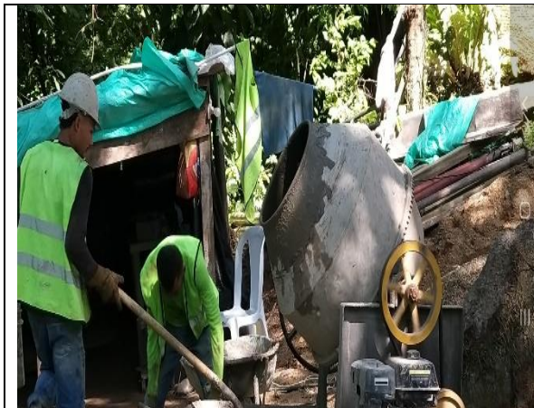
9. Obra en construcción acceso a visitantes Sector Zaino.
