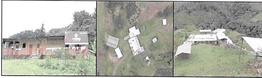
Figura 8. Aspecto de la zona de uso intensivo e infraestructura en la RNSC "LA ESMERALDA". Fuente: visita técnica PNNC
