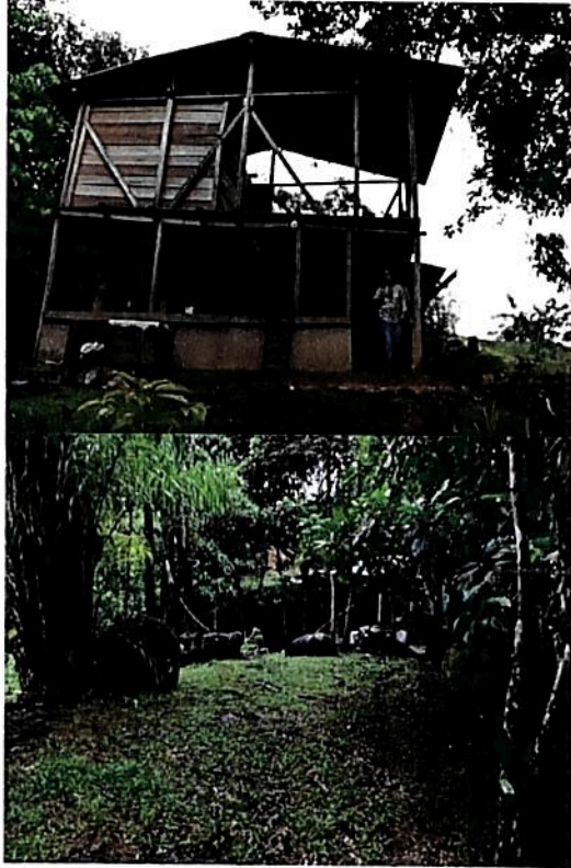
Figura 6. Zona de infraestructura y uso intensivo de la RNSC 055-22 ENTRE ARBOLES Y MICOS. Fuente: Informe Técnico CORNARE radicado 09174-2022.
