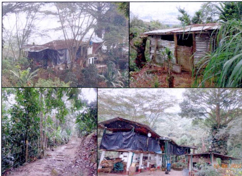
Figura 7. Aspecto de sectores de la zona de uso intensivo e infraestructura en la RNSC "MASHEDA". Fuente: visita técnica PNNC
