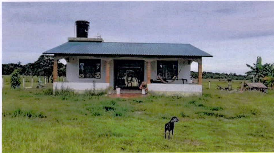
Imagen No. 9. Zona de Uso Intensivo e Infraestructura. Fuente: Visita técnica PNN.
