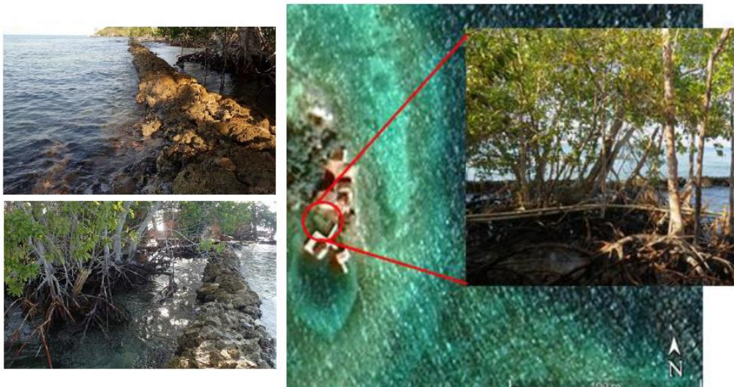
Figura 18. Estado del manglar y su ubicación con respecto al muro lineal (fuente: modificado de Invemar, 2022)
