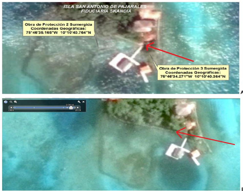
Figura 15. A.-Se aprecia acercamiento de la figura 13 -2013 en donde se señala la presencia de una estructura lineal, que en 2010 no se observaba debido a la cobertura vegetal. B- En 2016 la estructura lineal se aprecia a lo largo del borde sur de la isla.
