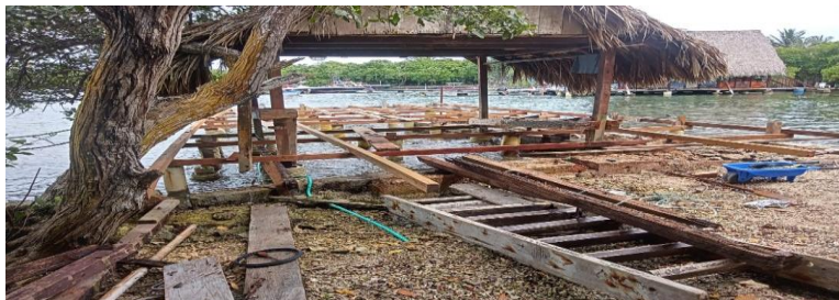
Reparación del muelle
