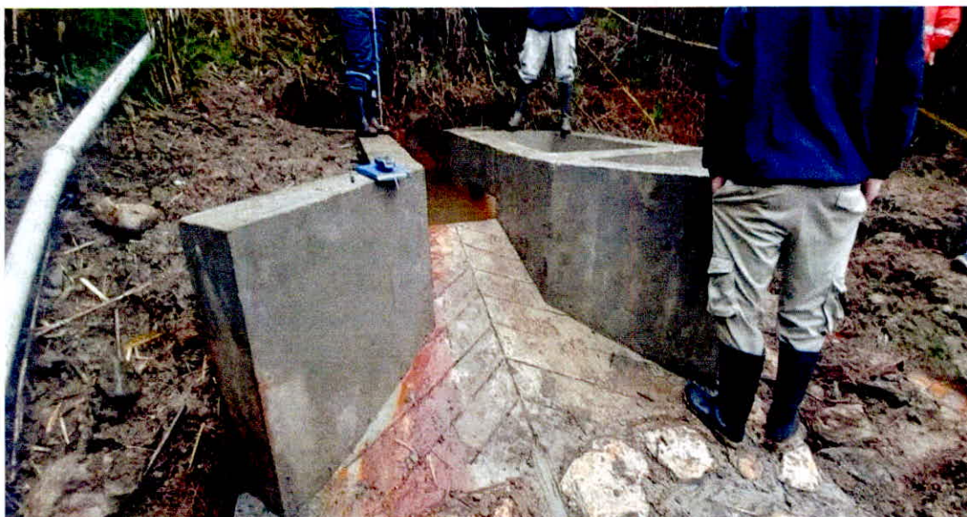
Figura 1. Bocatoma sector Compuertas. Fuente. Visita técnica 7 de marzo de 2023.
