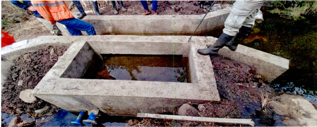
Figura 2. Obras Campamento Chuza Fuente: Visita técnica 7 de marzo de 2023.
