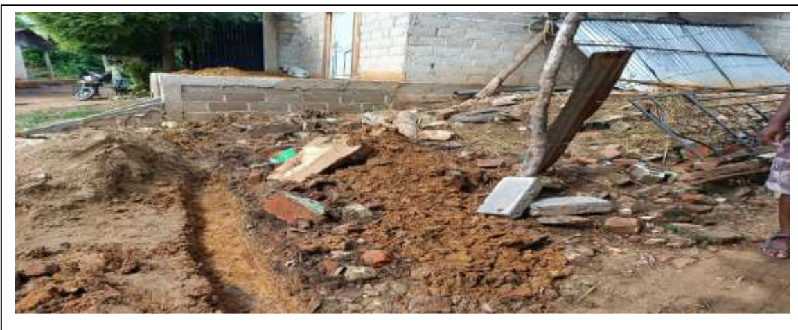
Foto 2. Vista lateral de la construcción, con proyección de construcción de un muro.
