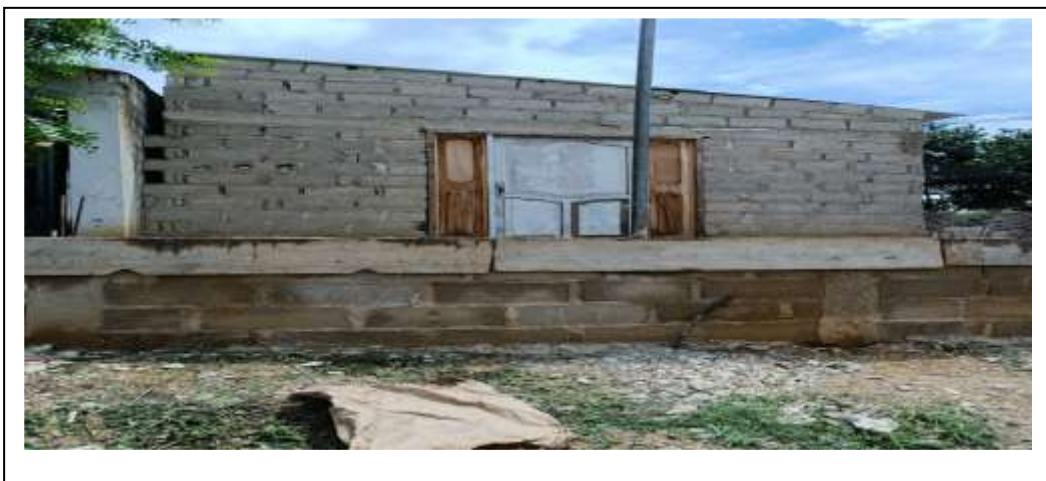
Foto 1. Vista frontal de la nueva construcción.
