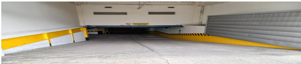
Imagen No. 39 Acceso Parqueadero.
