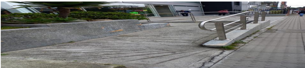
Imagen No. 42 Acceso Rampa Peatonal Discapacitados.
