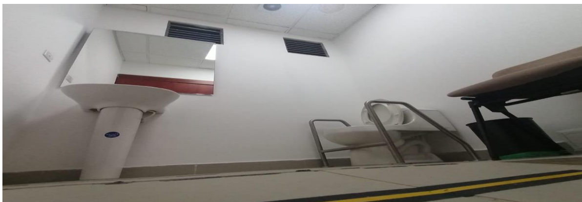
Imagen No. 44 Baño Discapacitados Primer Piso.
