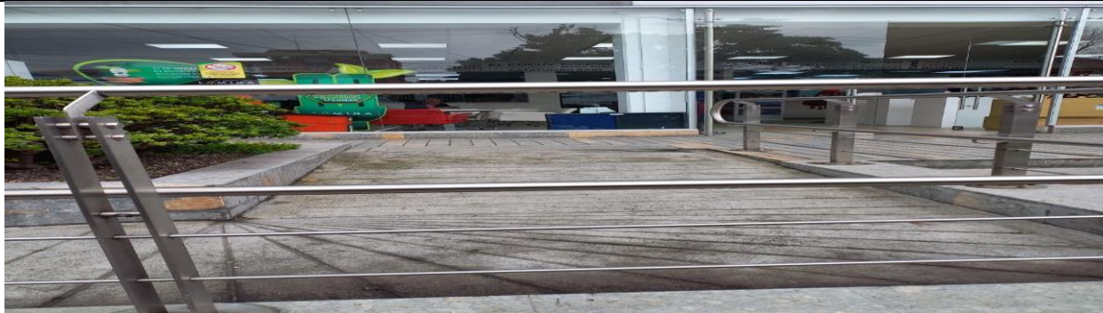
Imagen No. 43 Rampa Peatonal.
