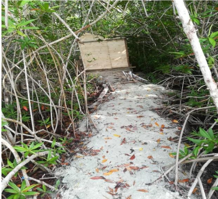
Fotografía 4. Area que fue talada y rellenada mediante el uso de arena coralina. Al fondo se observa estructura en madera.
